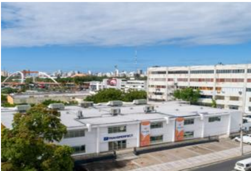
Edificio de Oficinas Ave. San Martín
