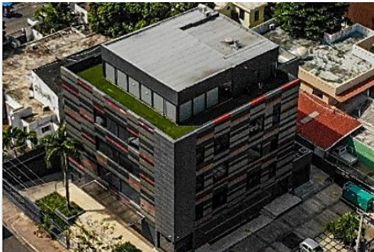
Edificio Ave. Núñez de Cáceres
